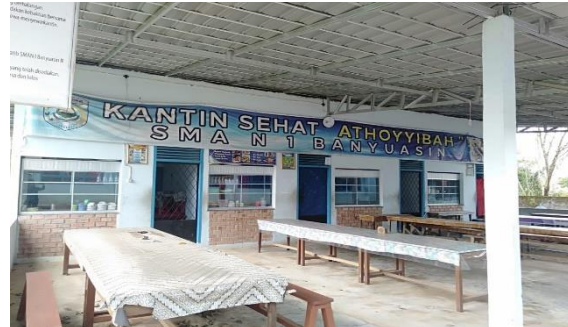
Gambar 2. Renovasi dan Perluasan Kantin Sekolah SMA Negeri 1 Banyuasin III
