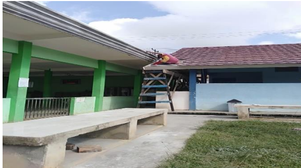
Gambar 1. Renovasi Pelebaran Mushollah SMA Negeri 1 Banyuasin III
